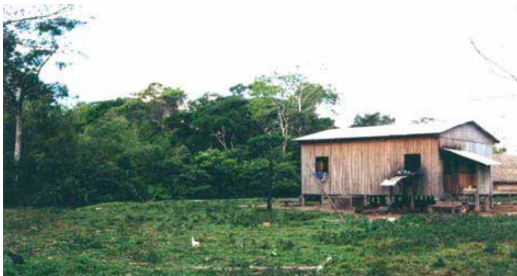
Figura 16 – Casa construída em área da floresta amazônica para extrativismo de borracha
