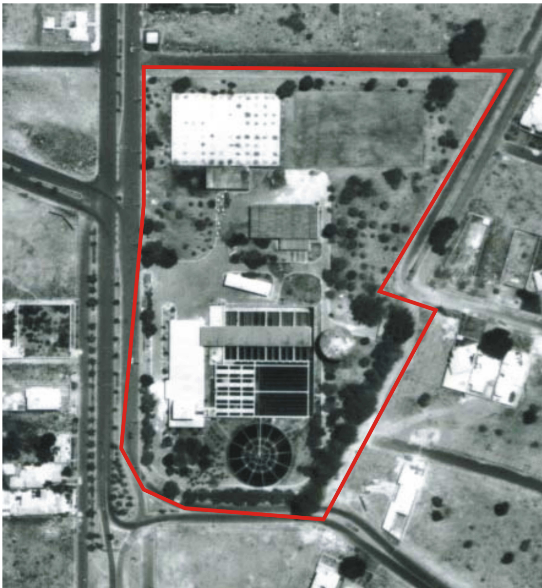
Vista aérea da Estação de tratamento de água do Bom Jardim
