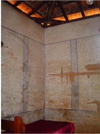
Figura 1- Detalhe pintura em quarto
