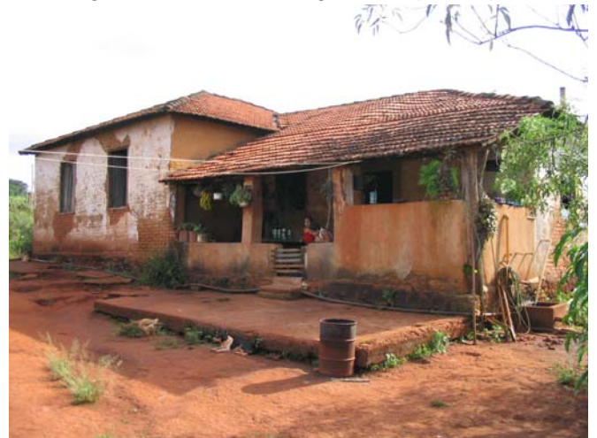
Foto 4 - Elevação direita vista dos fundos
