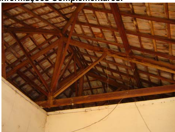
Figura 01: Detalhe interno - tesoura
