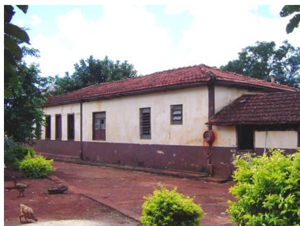
Fig.5 – Vista lateral direita: detalhe das esquadrias substituídas.
