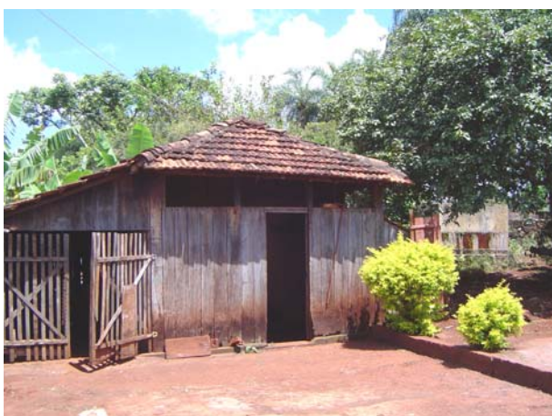
Fig.4 – Vista do depósito de insumos agrícolas.
